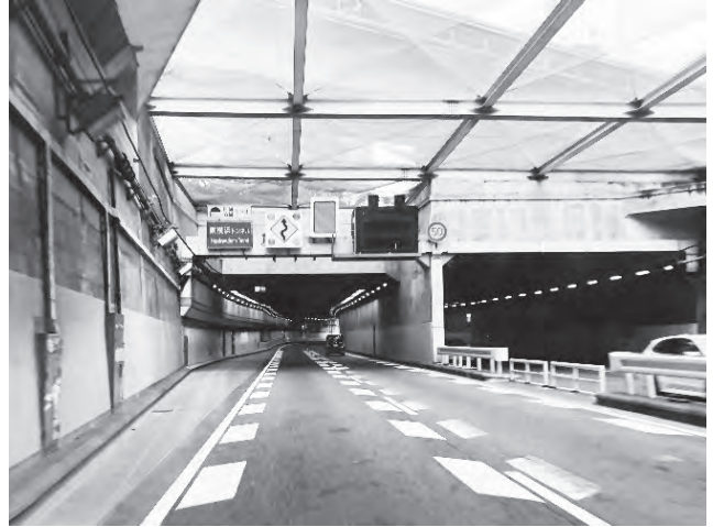
桜木町から石川町にかけての高速道路
